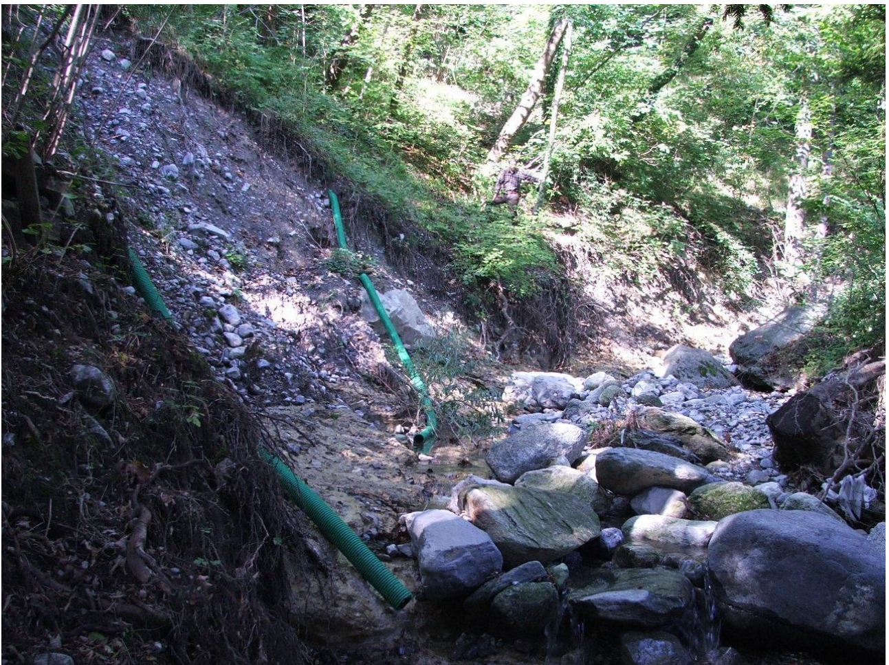
Val Sassina in comune di Rezzago – erosione in alveo
