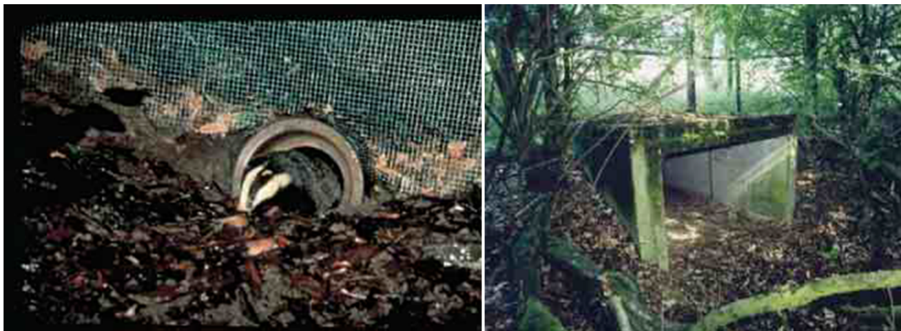
Esempi di sottopasso a sezione circolare e rettangolare
