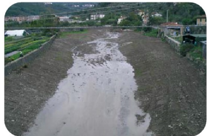
Fig. 2.11 Tipiche “pulizie d'alveo”. Sopra: sul Torrente Uso (Rimini) la vegetazione riparia (foto a sinistra) viene eliminata con ruspe fino a lasciare la sponda completamente “pulita” (foto a destra). Sotto: effetti (devastanti) di una “pulizia d'alveo” e rimodellamento della sezione nell’Ombrone pistoiese (Foto in alto: G. Conte; in basso: B. Boz).
