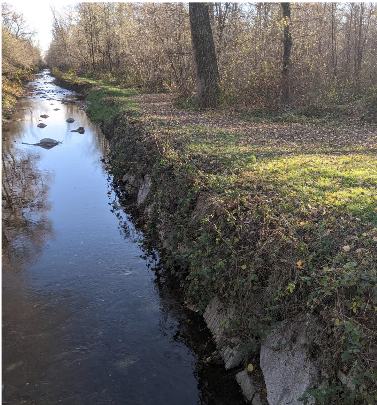
Immagine 8 Tratto di torrente Bozzente rettificato
