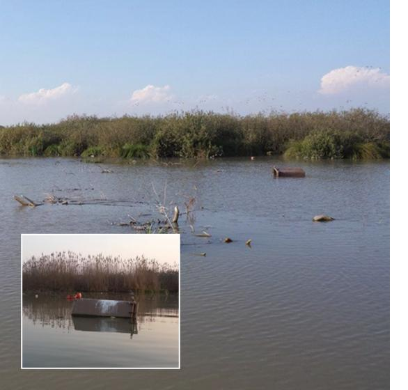
• Creazione bacini di decantazione volti alla sedimentazione del materiale più grossolano e creazione di **bacini di fitodepurazione** ovvero aree umide artificiali che attraverso l'attività delle piante e dei microrganismo batterici sono in grado di sottrarre alle acque gli inquinanti ed i nutrienti in eccesso.
