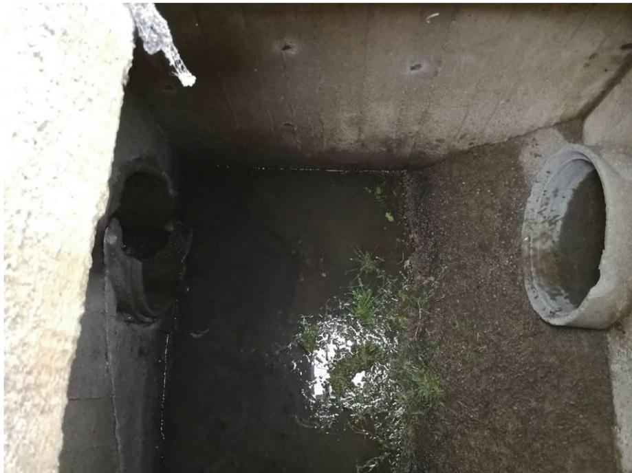
*Pozzetto 2 : dettaglio delle due tubazioni (ingresso da Sud) e uscita verso Nord (vs. R. Segià)*
