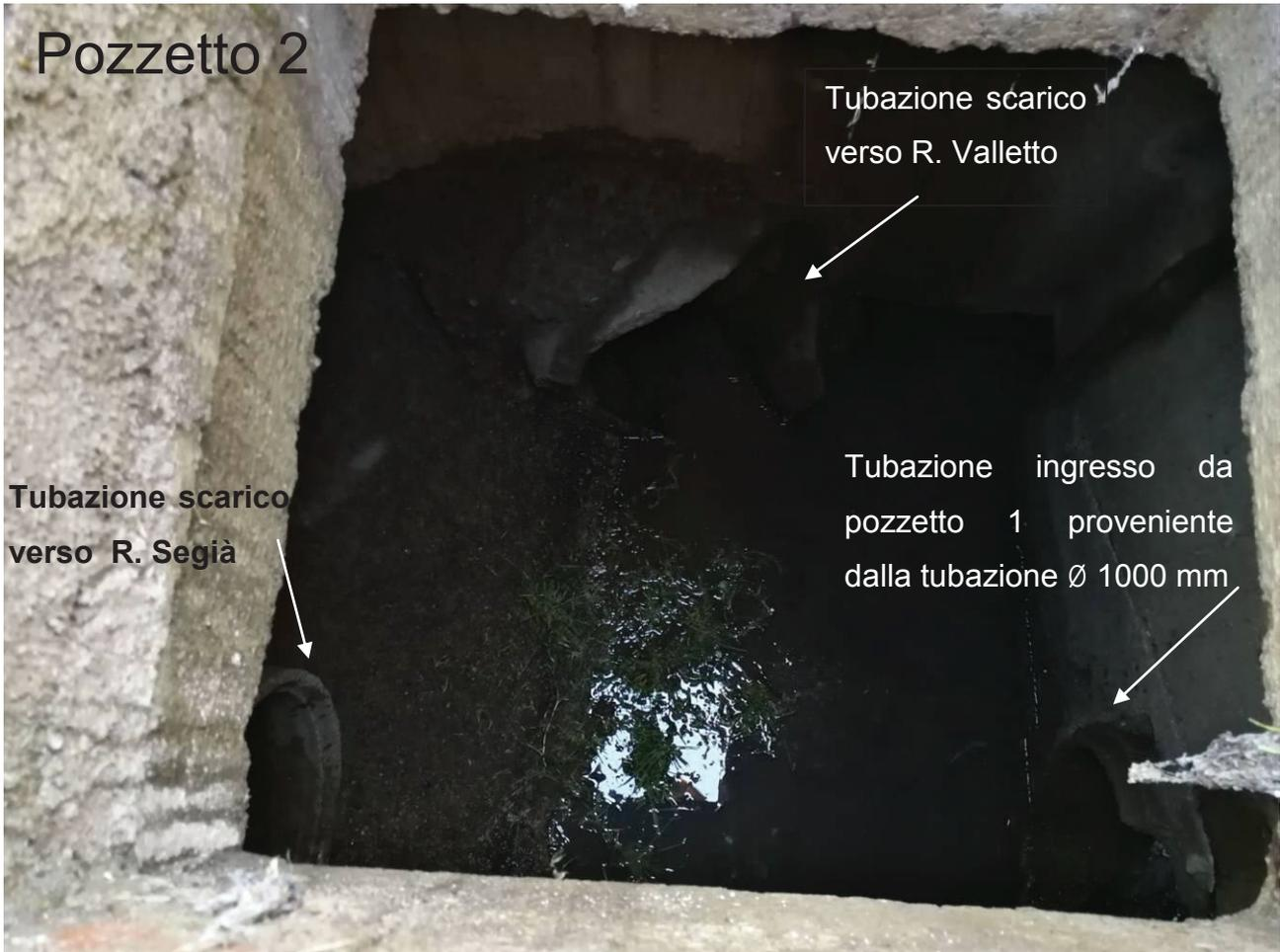
*Pozzetto 2 : visione d'insieme delle tre tubazioni presenti entro il pozzetto*
