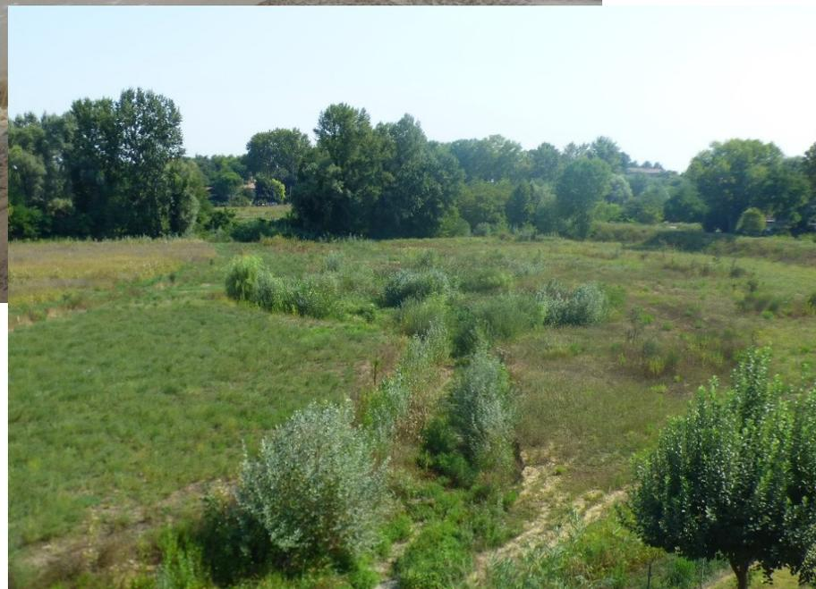
Oggi, il percorso del rio è stato allontanato dagli edifici, rimosso il rivestimento in calcestruzzo di fondo e sponde, meandrizzato e dotato di una ampia lanca (allargamento d'alveo) che svolge funzioni ambientali di zona umida con valenze fitodepurative.
