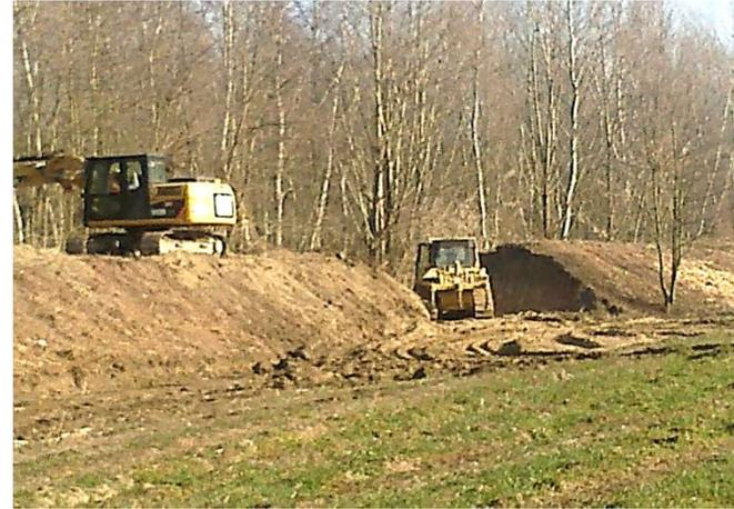
un secondo grande intervento è stato completato nel 2015, è stata realizzata la rimozione delle arginature che consente una laminazione ampia laddove oggi gli alvei raggiungono una ampiezza di quasi 500 metri. Sono stati demoliti **circa 3 km di rilevati arginali** in destra Montone e sinistra Rabbi. La zona dell'intervento è a ridosso del complesso ospedaliero Morgagni Pierantoni a Vecchiazzano a fronte del Parco Urbano, **in giallo**. Fenomeni di recupero morfologico si sono avviati.
