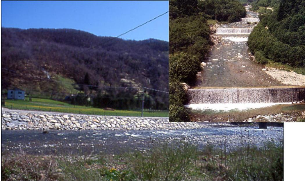
Molte opere idrauliche, come s'è visto, accentuano la forza erosiva delle piene e, con ciò, inducono l'instabilità del fondo e delle sponde. Ecco allora che, per stabilizzare gli alvei, si interviene con ulteriori artificializzazioni: briglie, soglie, difese spondali.
