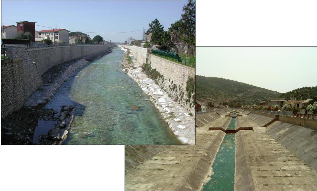
Rettifiche e canalizzazioni sono finalizzate ad accelerare l'allontanamento delle portate di piena.
