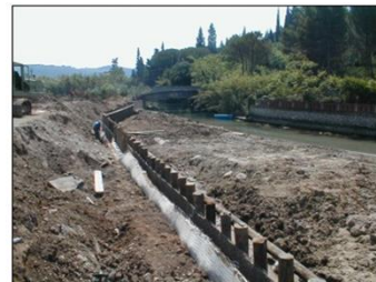
Palificata e gabbioni cilindrici
